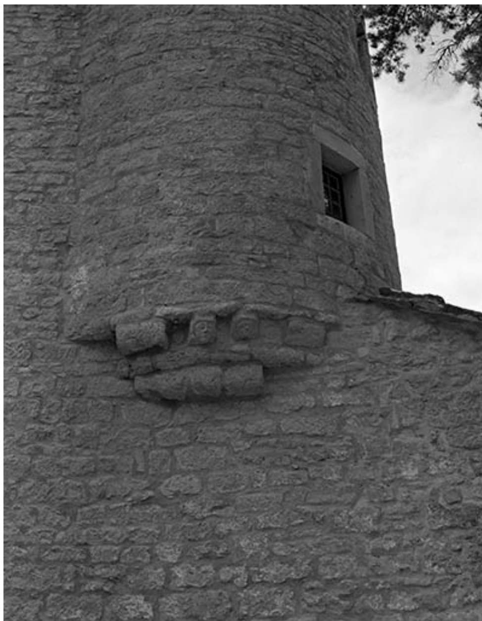
Encorbellement de la tourelle de l'angle nord-est
