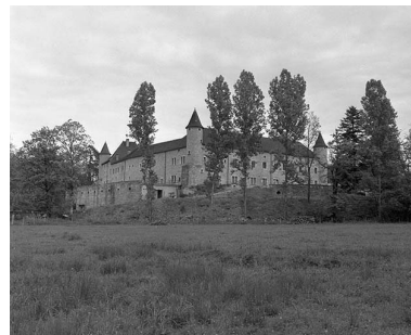
Façades nord et ouest. Phot. Yves Sancey IVR43_19813900086X
