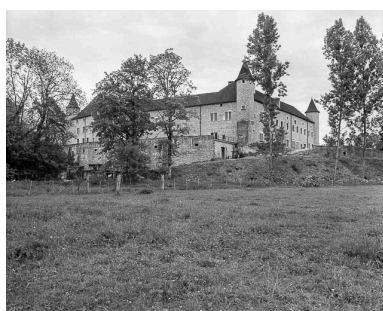
Façades nord et ouest. Phot. Yves Sancey IVR43_19813900087X
