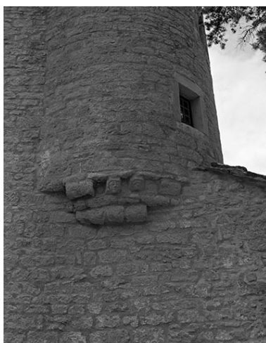
Encorbellement de la tourelle de l'angle nord-est Phot. Yves Sancey IVR43_19813900090X
