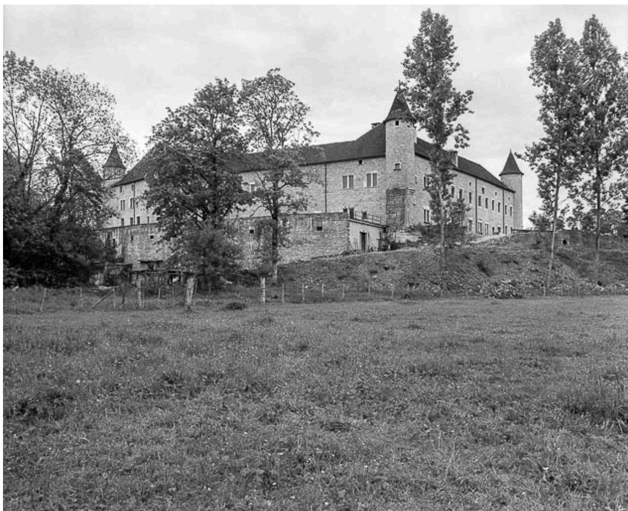
Façades nord et ouest.
