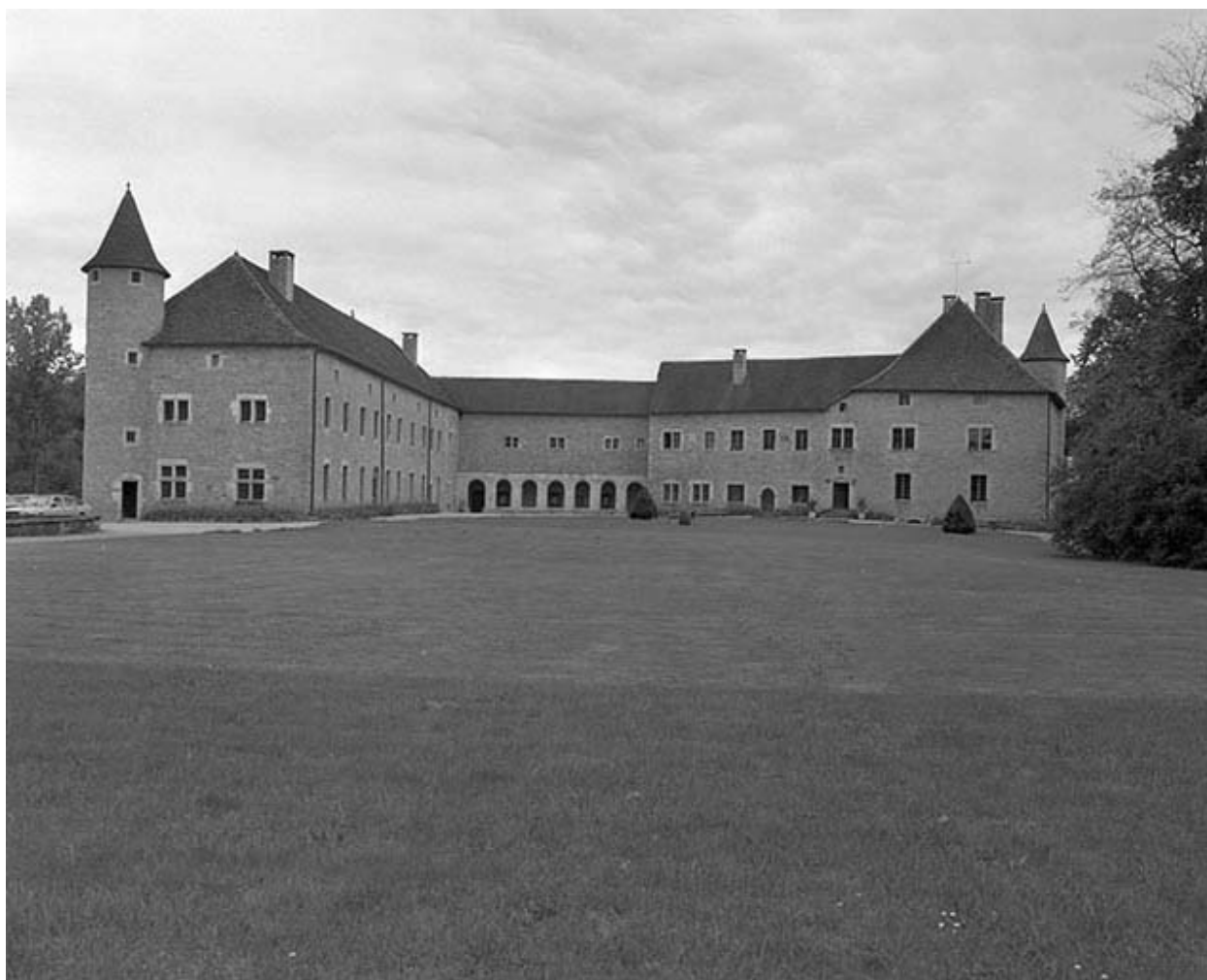
Façades sud et est.
