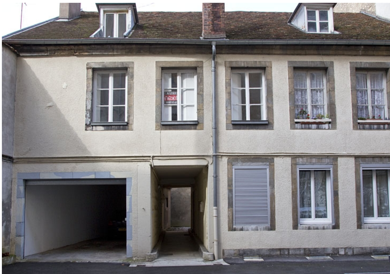
Logis secondaire, façade antérieure, de face.
