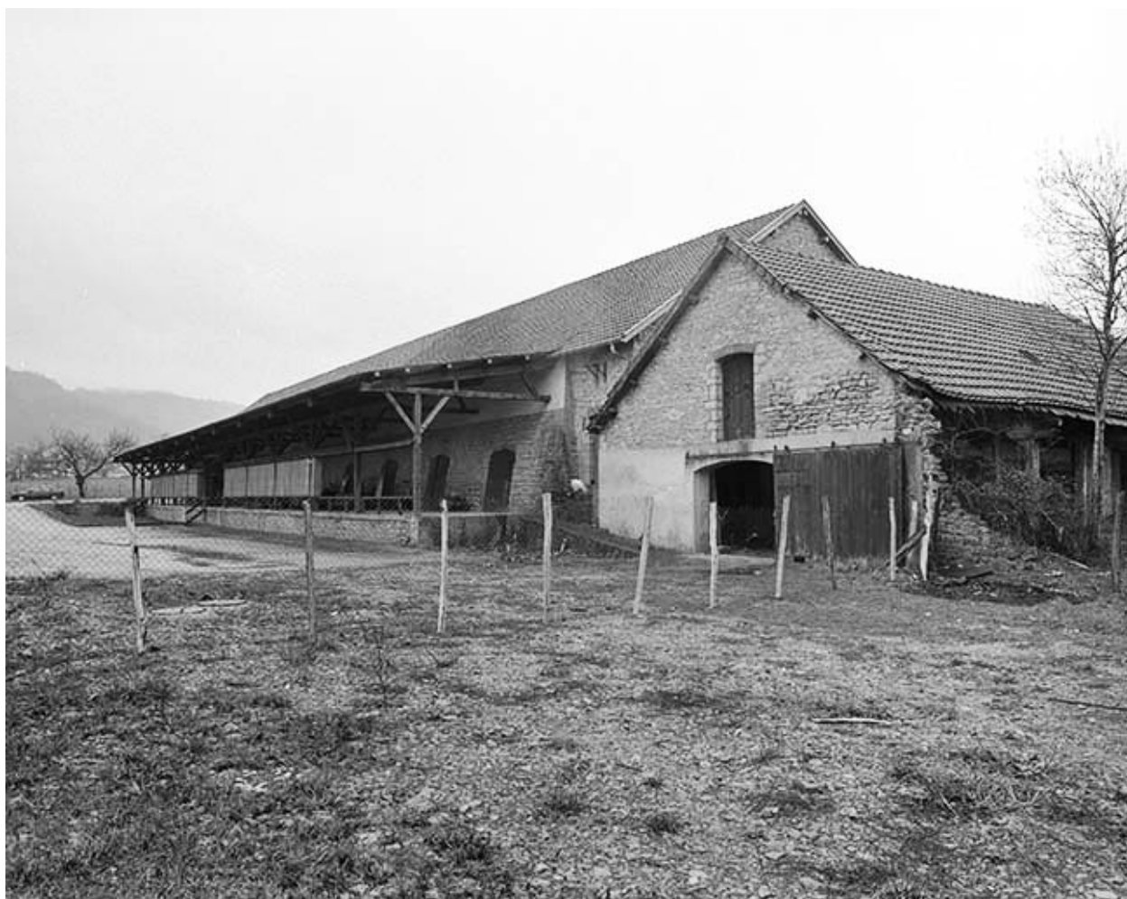
Magasin industriel et atelier de fabrication ruiné.
