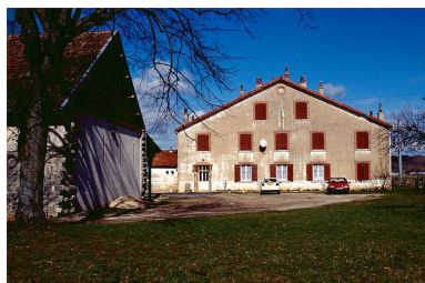
Bâtiment abritant les bureaux et le logement. Phot. Yves Sancey IVR43_19973900439ZA
