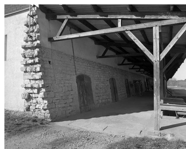
Mur nord du magasin industriel. Phot. Yves Sancey IVR43_19983900019X
