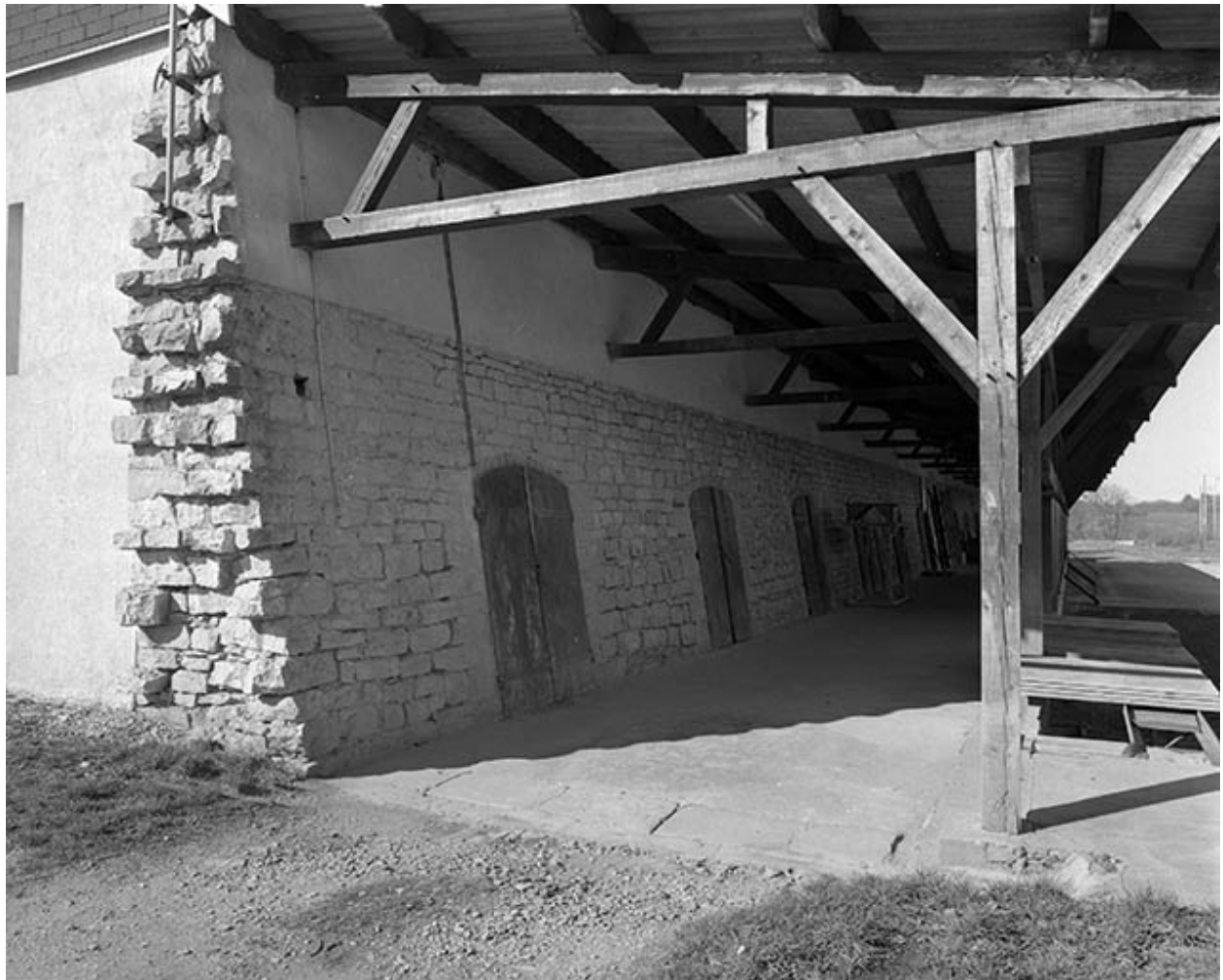
Mur nord du magasin industriel.
