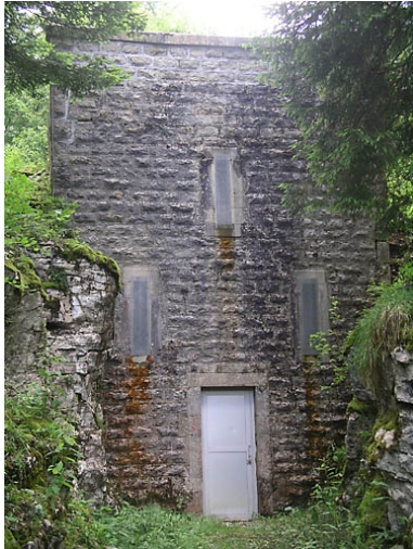
Vue générale sur construction hydraulique. Phot. Anne-Laure Madinier IVR43_20083900619NUC1A
