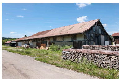
Façades est de l'atelier de scierie. Phot. Jérôme Mongreville IVR43_20162500420NUC4A
