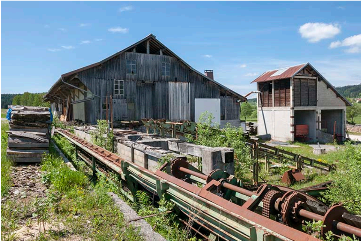
Pignon nord de l'atelier de scierie et sciurier.
