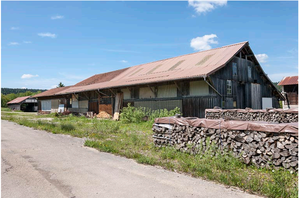
Façades est de l'atelier de scierie.
