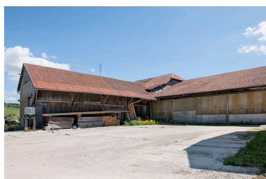
Cour de la scierie. Phot. Jérôme Mongreville IVR43_20162500423NUC4A
