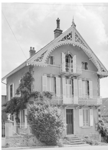
Façade principale sur l'avenue Eugène Collin, vue en 1978. Phot. Michel Rosso IVR26_19785800225V
