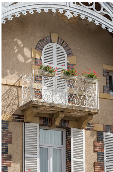
Baie et balcon du second étage. Phot. Pierre-Marie Barbe-Richaud IVR26_20195800692NUC4A
