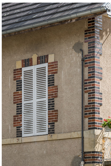
Encadrement de baie et chaîne d'angle harpée en brique vernissée. Phot. Pierre-Marie Barbe-Richaud IVR26_20195800691NUC4A
