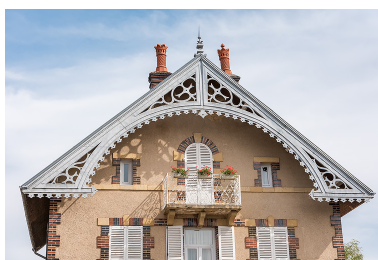
Pignon protégé par une large saillie de rive décorée d'un lambrequin métallique découpé. Phot. Pierre-Marie Barbe-Richaud IVR26_20195800694NUC4A
