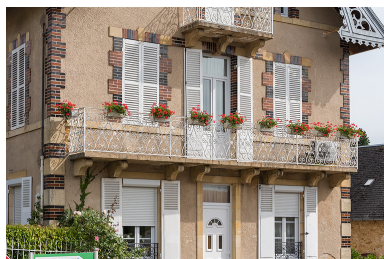
Baies et balcons du premier étage. Phot. Pierre-Marie Barbe-Richaud IVR26_20195800695NUC4A
