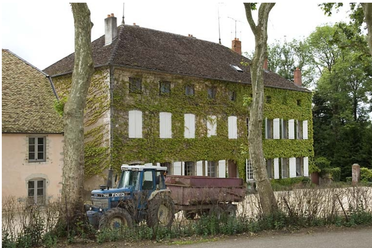
Logement patronal vu de trois quarts.
