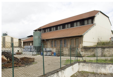
Atelier de fonderie depuis le sud-est. Phot. Jérôme Mongreville IVR43_20087000720NUC2A
