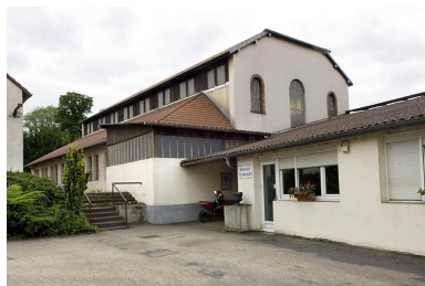
Atelier de fonderie depuis la cour. Phot. Jérôme Mongreville IVR43_20087000713NUC2A
