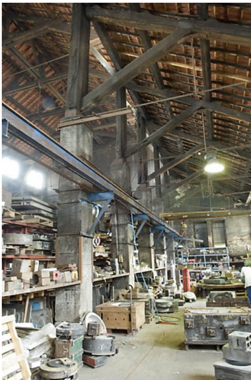
Atelier de fonderie. Le bas-côté sud.
