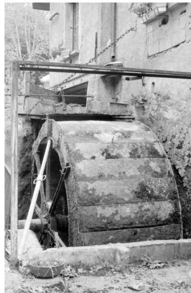
Roue en dessus et conduite d'amenée, vues de face. Phot. Laurent Poupard IVR43_19933900536Z
