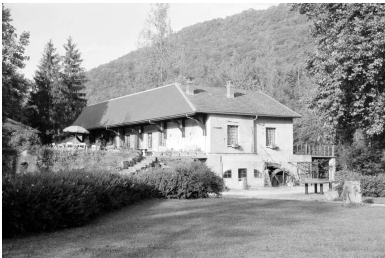
Bâtiment d'eau, vu de trois quarts droite.
