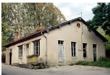
Atelier (B), vu de trois quarts droite. Phot. Laurent Poupard IVR43_19933900520ZA
