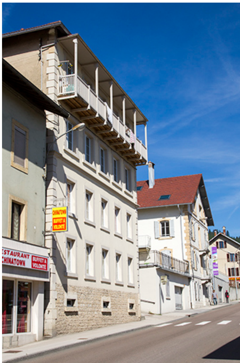
Usine : façade antérieure, vue en enfilade.
