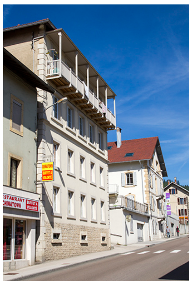
Usine : façade antérieure, vue en enfilade. Phot. Yves Sancey IVR43_20132502303NUC2A
