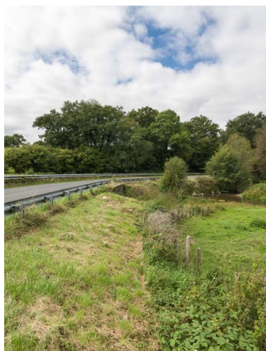
Vue de l'aqueduc. Phot. Pierre-Marie Barbe-Richaud IVR26_20177100312NUC2A
