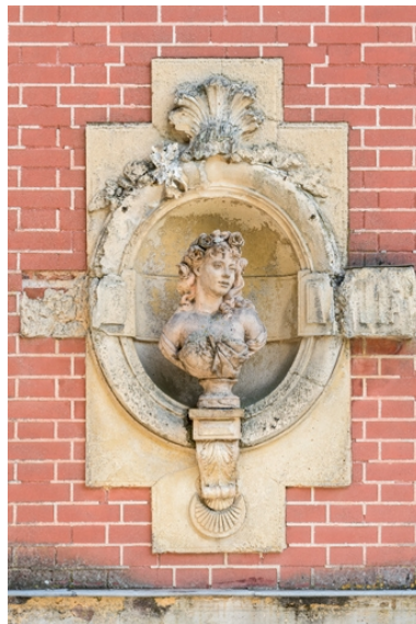
1er buste (à gauche sur l'élévation des communs). Phot. Pierre-Marie Barbe-Richaud IVR26_20222100874NUC4A
