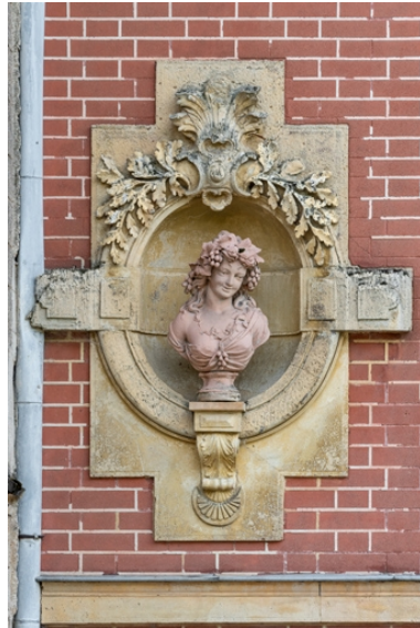
3e buste (à gauche sur l'élévation de la maison). Phot. Pierre-Marie Barbe-Richaud IVR26_20222100868NUC4A
