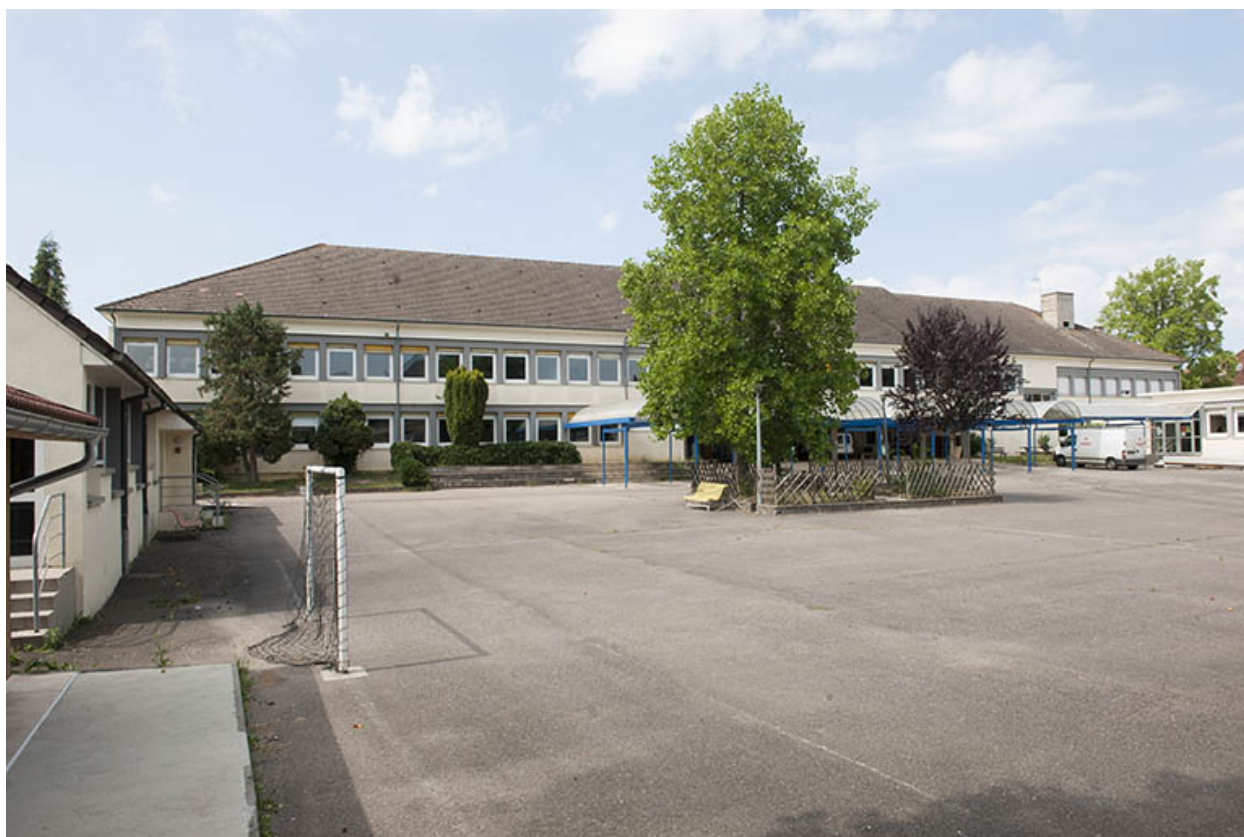
Vue générale sur la cour.
