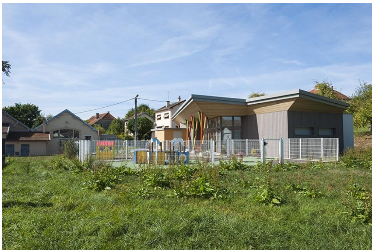
Vue d'ensemble de la crèche.
