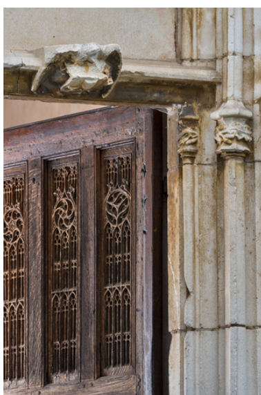
Porte de la chapelle, détail. Phot. Pierre-Marie Barbe-Richaud IVR26_20237100216NUC4A
