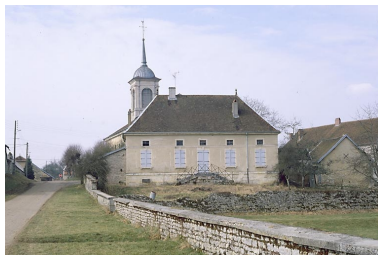
Façade postérieure. Phot. Yves Sancey IVR43_19857000099XA
