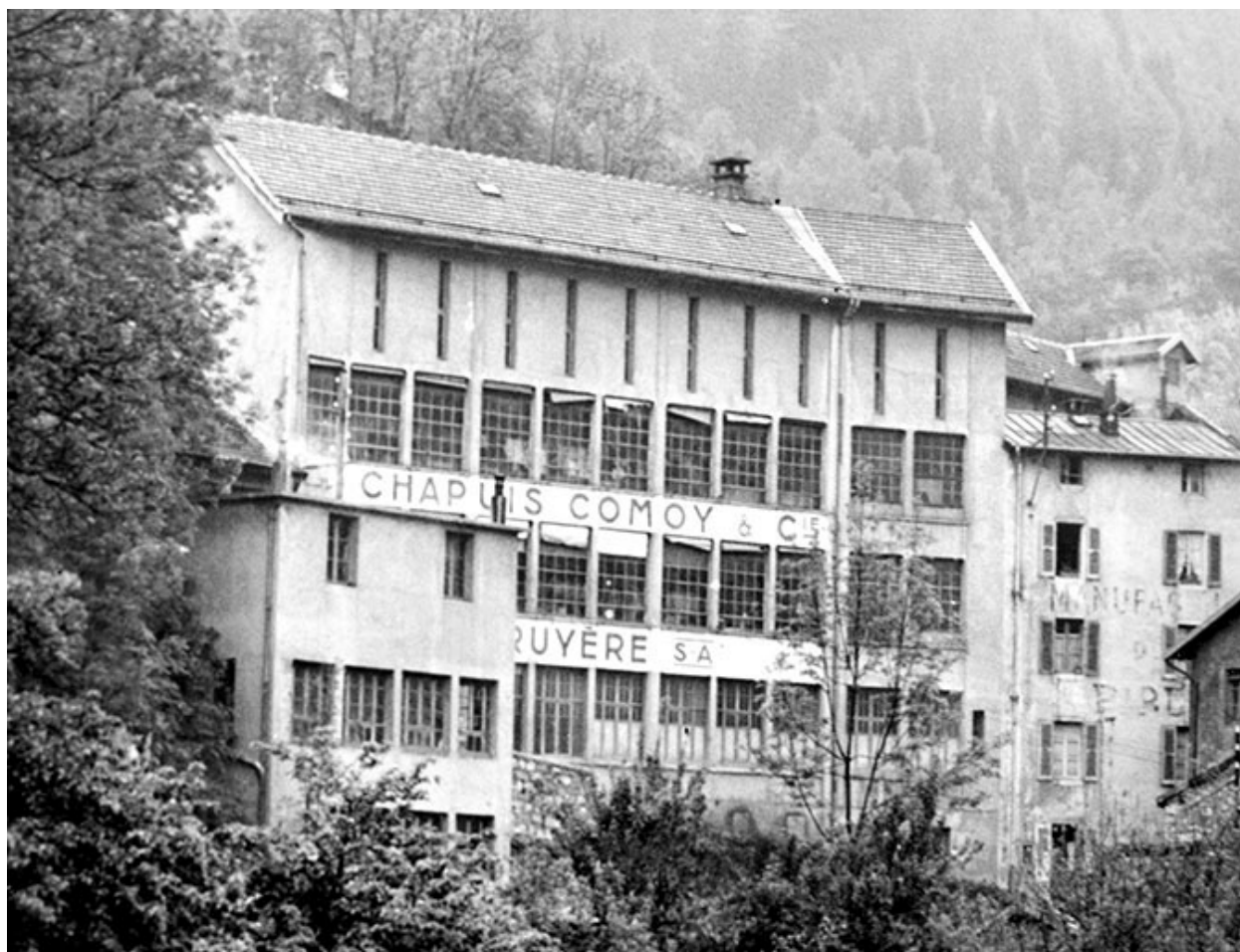
[Façades sur la rue des Etapes], [milieu 20e siècle].
