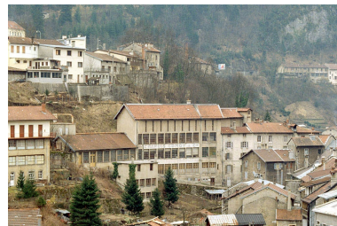
Vue d'ensemble depuis le nord. Phot. Laurent Poupard IVR43_19923901379ZA
