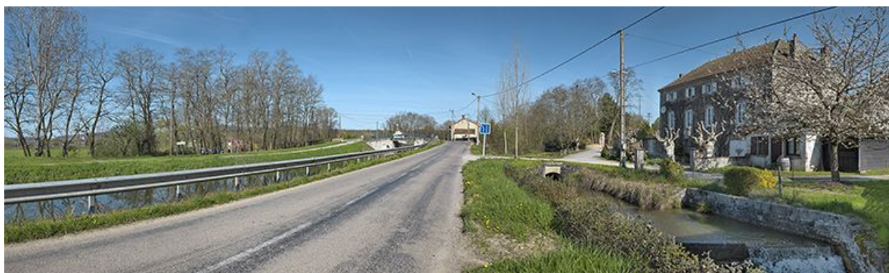
Rigole d'alimentation derrière la maison éclusière.
