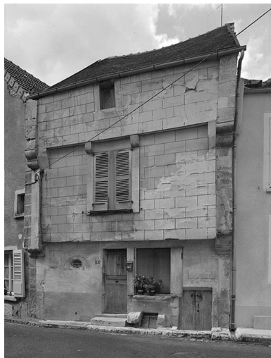
Façade sur rue. Phot. Jean-Luc Duthu IVR26_19748901255V
