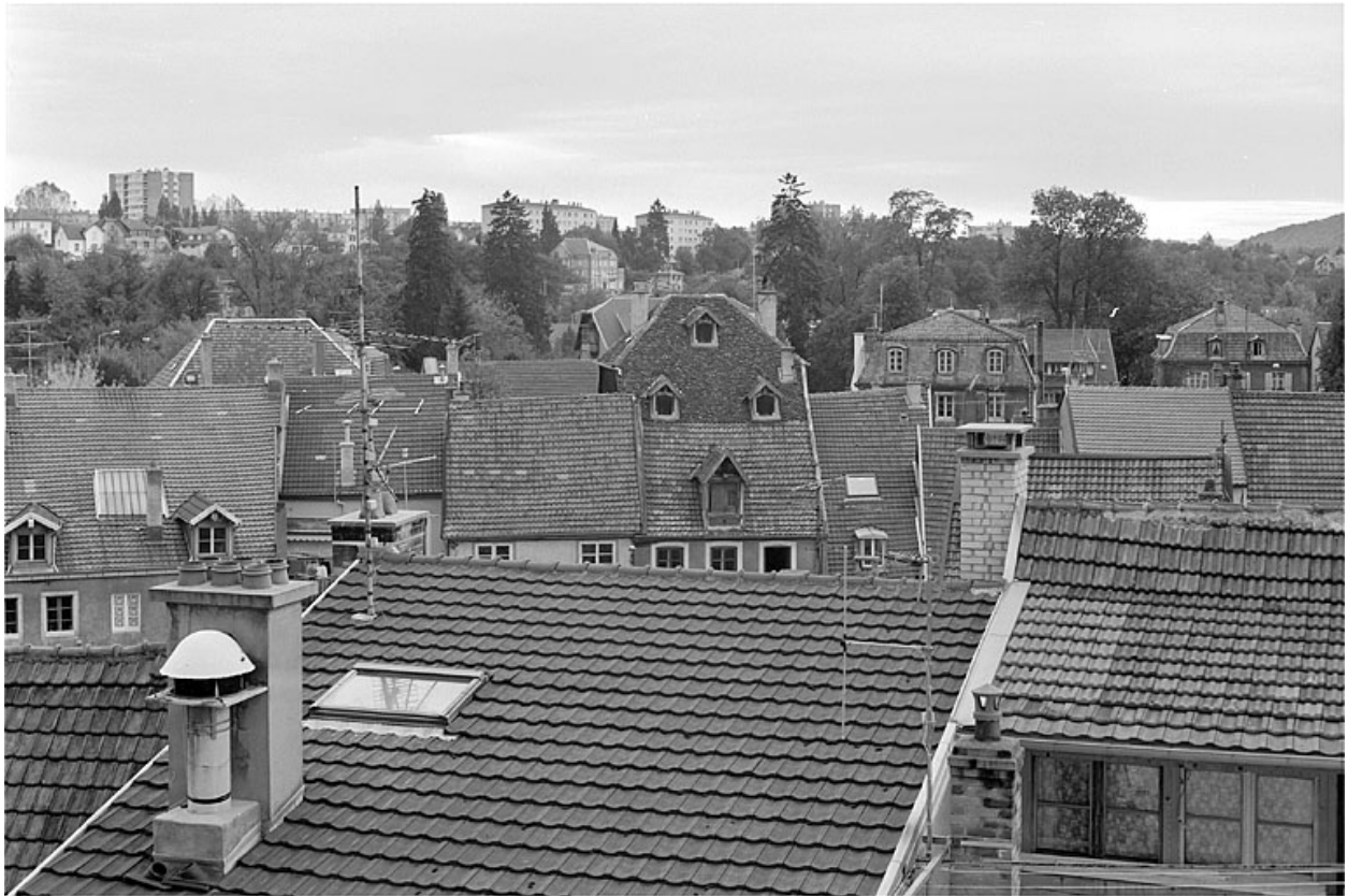
Vue d'ensemble de la toiture.
