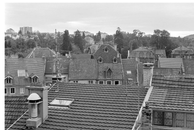
Vue d'ensemble de la toiture. Phot. Jérôme Mongreville IVR43_19872501031X
