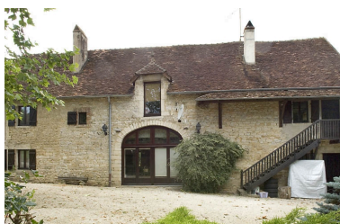
Logement ouvrier ouest. Phot. Jérôme Mongreville IVR43_20087000931NUC2A
