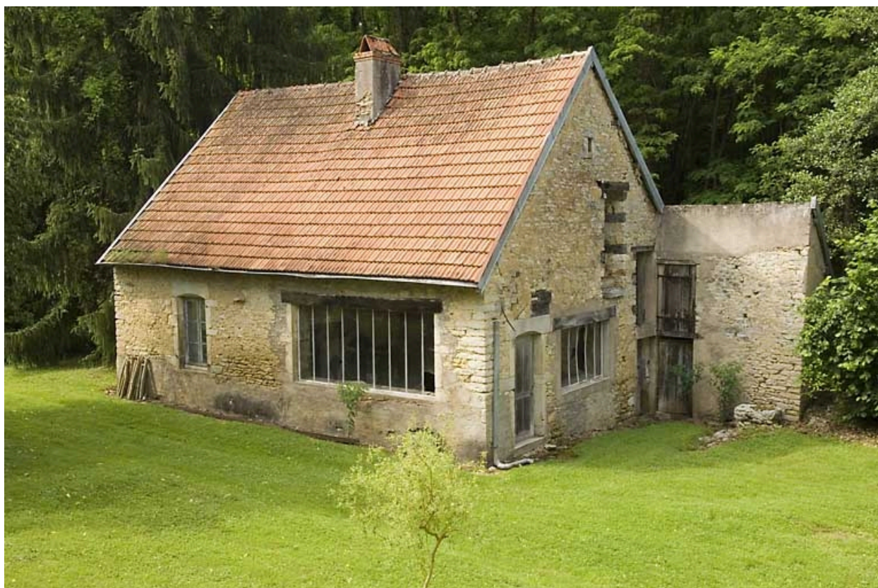
Logement ouvrier nord.
