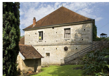
Façade ouest du haut fourneau. Phot. Jérôme Mongreville IVR43_20087000926NUC2A
