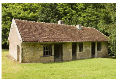
Logement ouvrier (tronqué). Phot. Jérôme Mongreville IVR43_20087000923NUC2A
