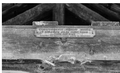
Entrait de la charpente du haut fourneau en 1979. Détail d'une plaque signalétique.
