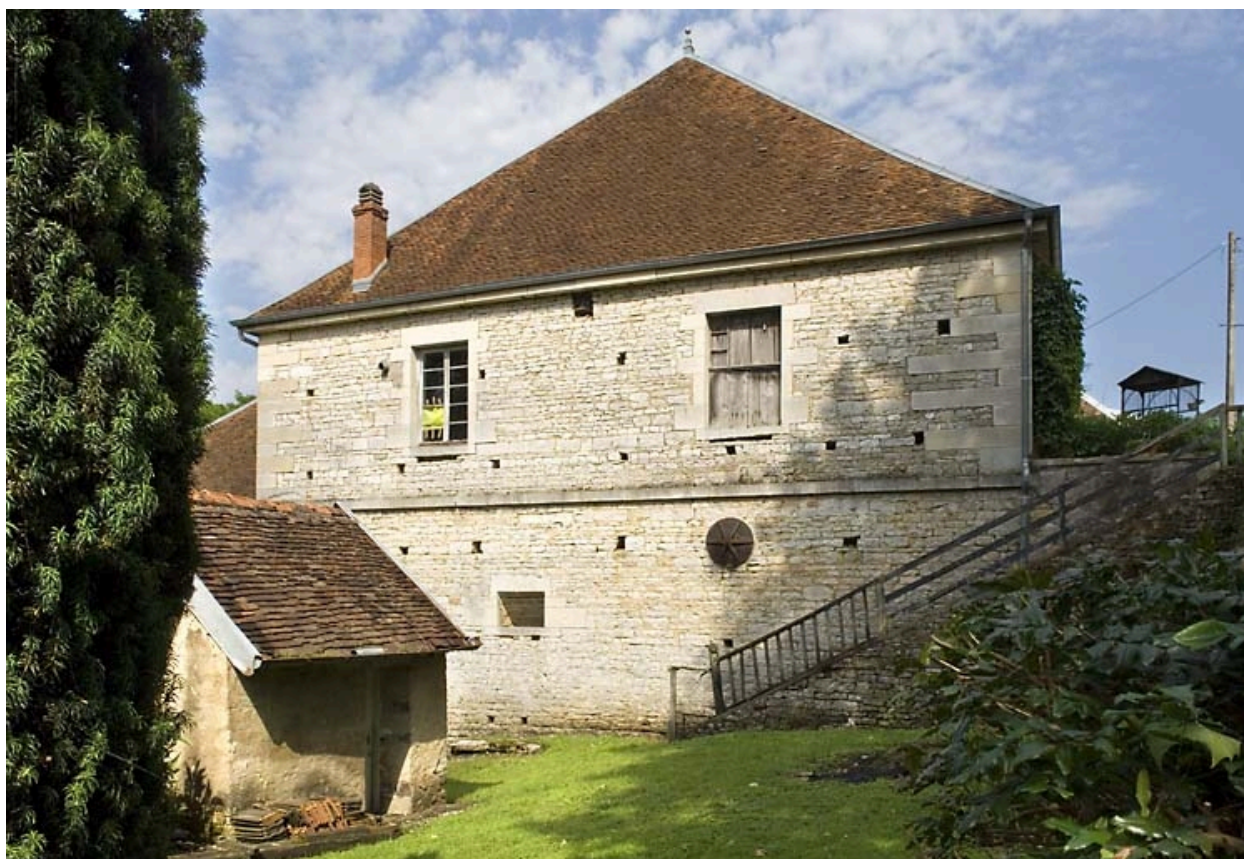
Façade ouest du haut fourneau.
