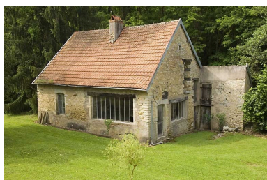
Logement ouvrier nord. Phot. Jérôme Mongreville IVR43_20087000922NUC2A
