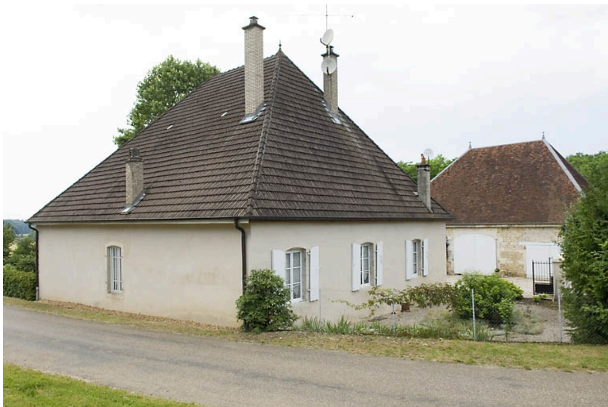
Logement patronal et haut fourneau.
