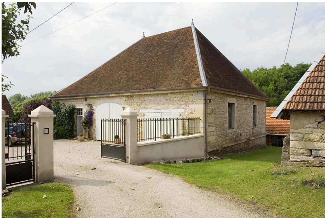
Le haut fourneau vu depuis le sud-est.
