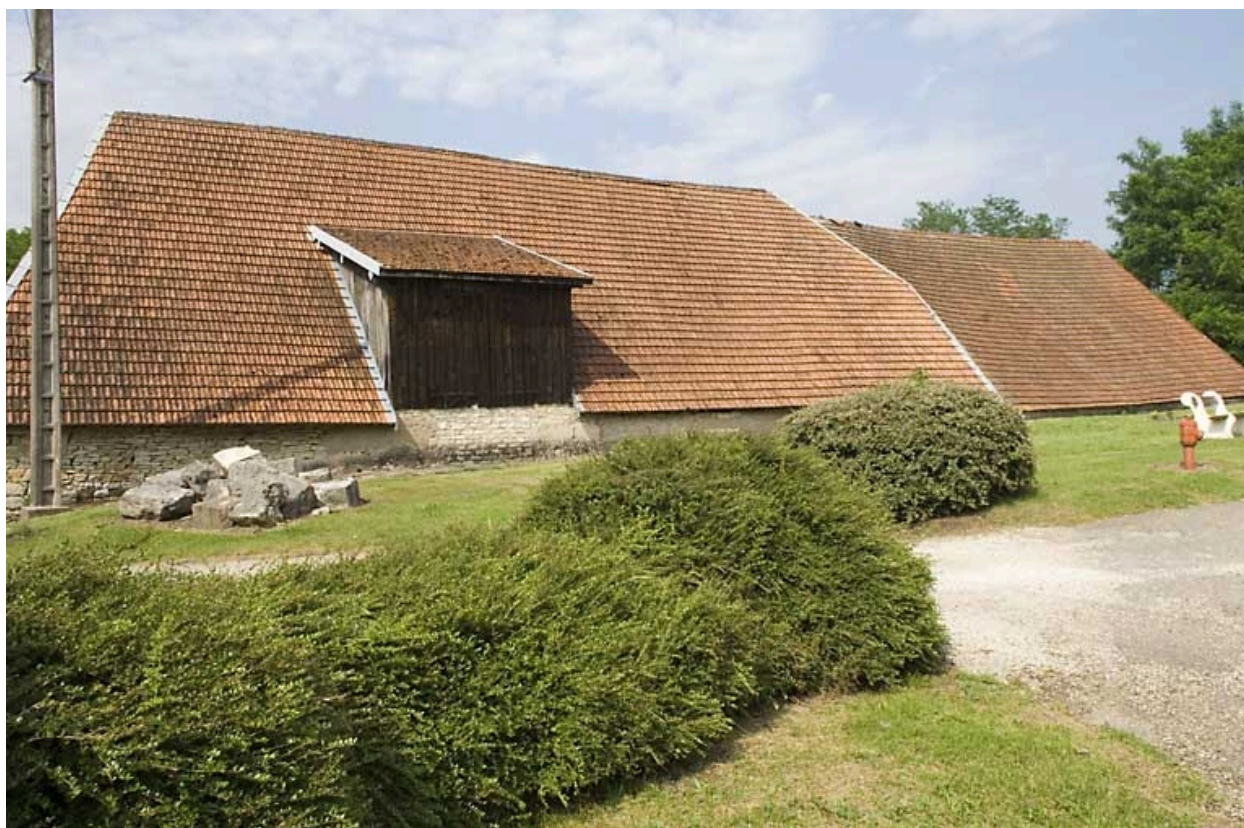
Vue d'ensemble de la halle à charbon.
