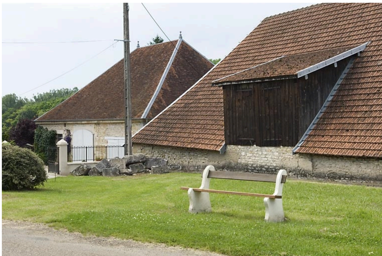
Le haut fourneau et la halle à charbon.
