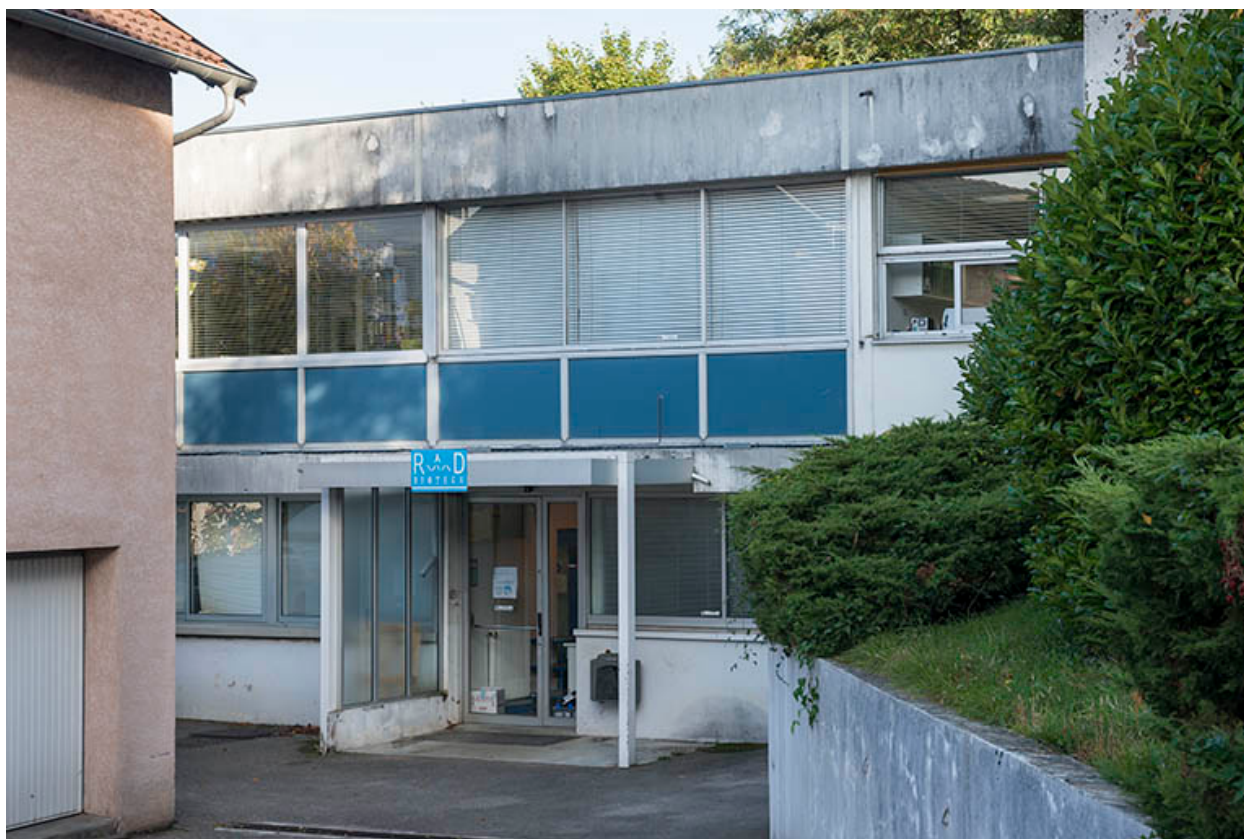
Façade sud de l'extension.
