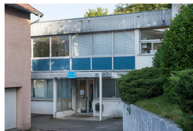
Façade sud de l'extension. Phot. Jérôme Mongreville IVR43_20172501145NUC4A
