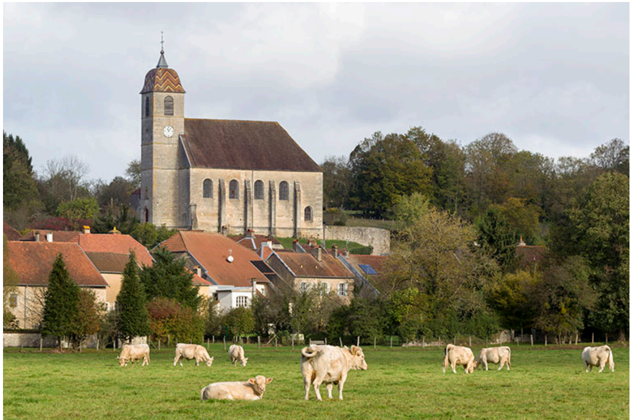
Vue générale en direction du Breuil.
