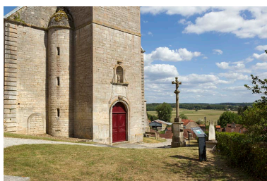
Vue du rez-de-chaussée de la tour-clocher. Phot. Sonia Dourlot IVR43_20167000684NUC4A
