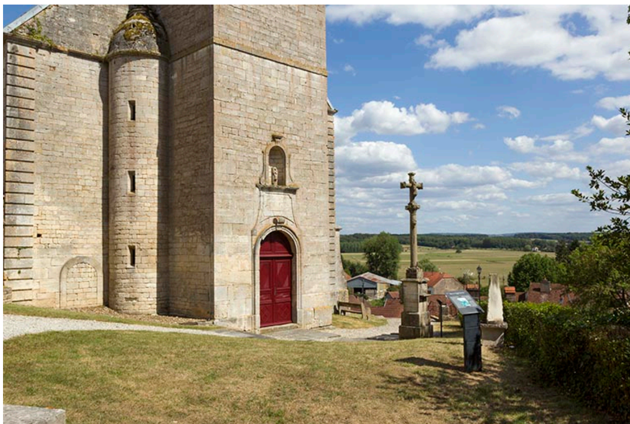
Vue du rez-de-chaussée de la tour-clocher.
