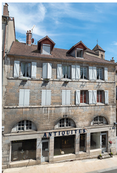
Façade antérieure. Phot. Jérôme Mongreville IVR43_20233900856NUC4A
