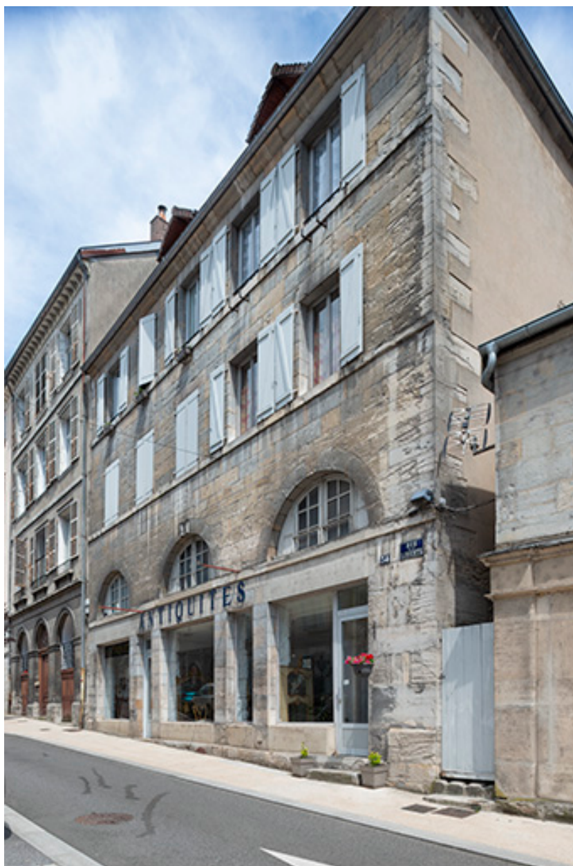
Façade vue de trois quarts droite.
