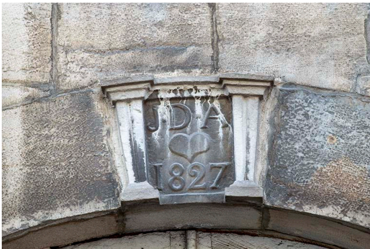
Façade antérieure. Clef de l'arcade centrale.
