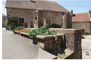
Vue de trois quarts droit. Phot. Jérôme Mongreville IVR43_20102500658NUC4A
