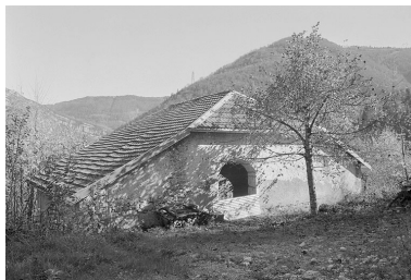
Face ouest. Phot. Jérôme Mongreville IVR43_19963901678X
