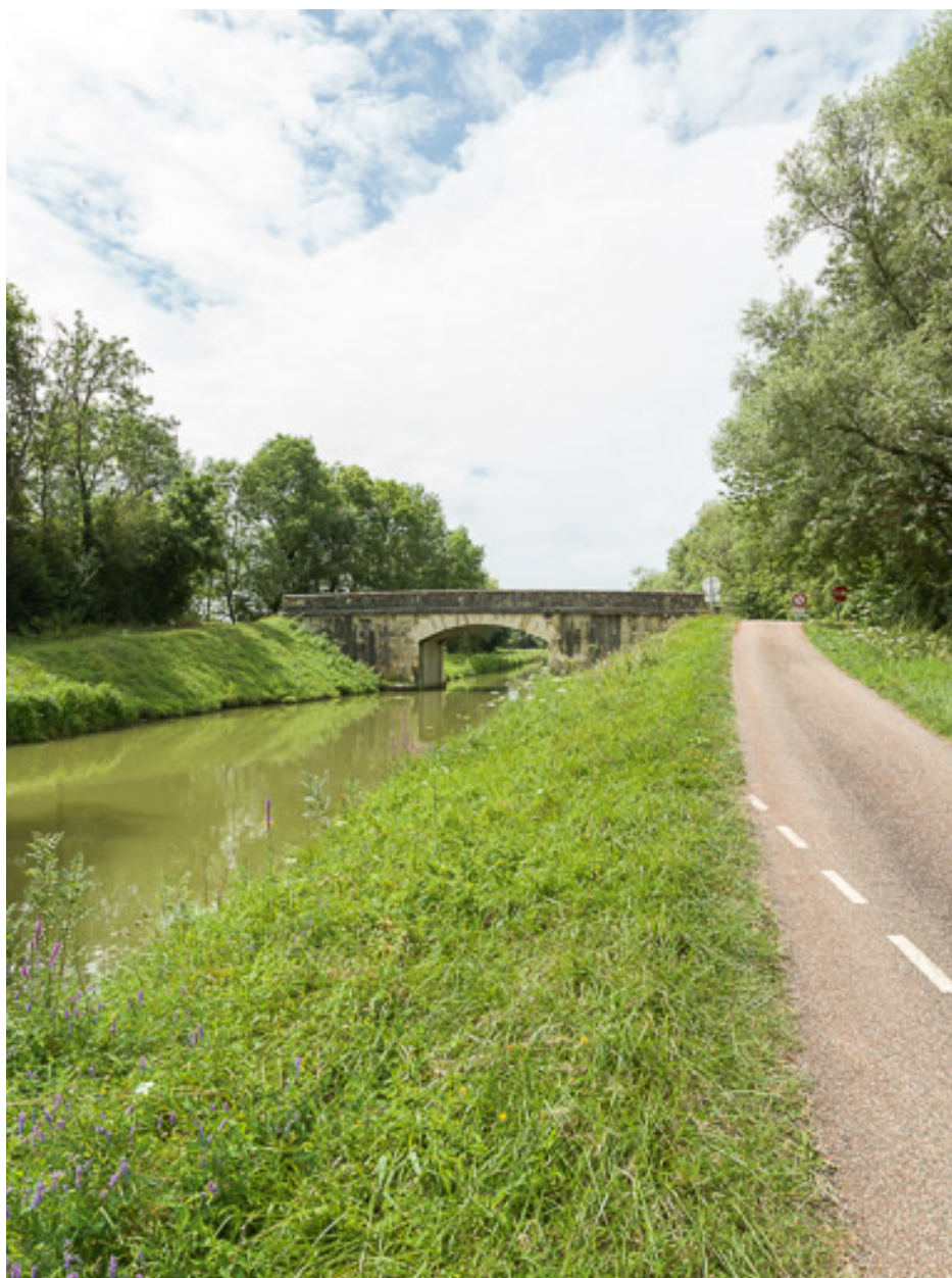
Vue d'ensemble du pont et du site.
