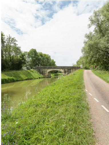
Vue d'ensemble du pont et du site. Phot. Pierre-Marie Barbe-Richaud IVR26_20175800191NUC2A
