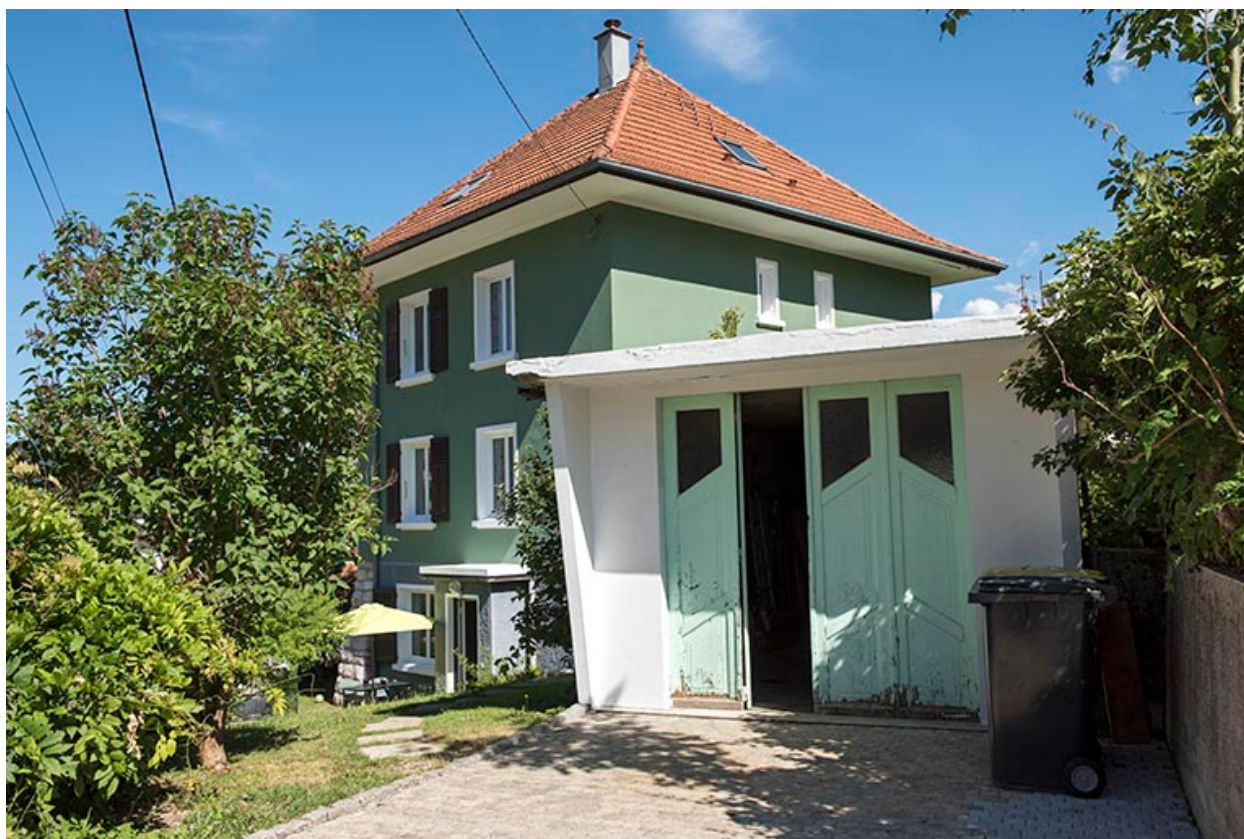
Garage et façade latérale droite.
