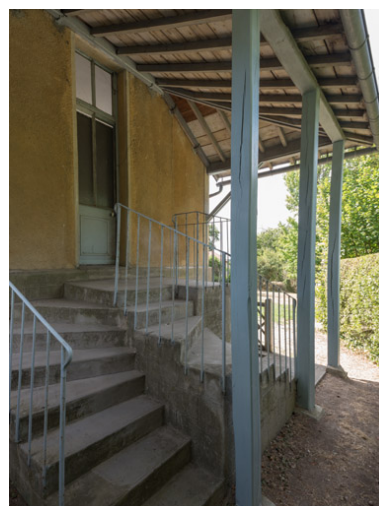
Entrée latérale, côté nord. Phot. Pierre-Marie Barbe-Richaud IVR26_20195800616NUC4AQ
