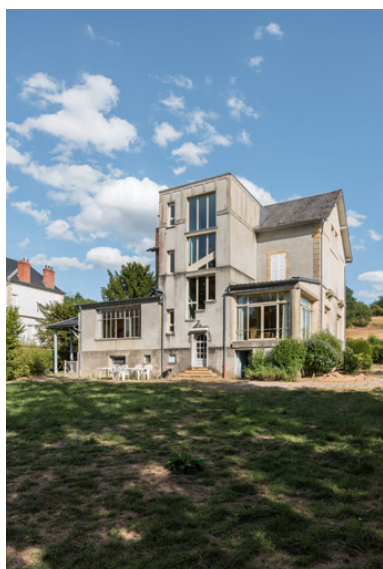
Vue depuis l'ouest. Phot. Pierre-Marie Barbe-Richaud IVR26_20195800626NUC4A
