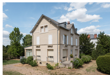
Vue depuis le sud. Phot. Pierre-Marie Barbe-Richaud IVR26_20195800614NUC4A
