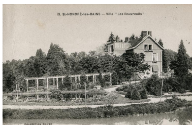
Vue du jardin et de la villa depuis le sud-ouest. Phot. auteur inconnu IVR26_20195800106NUC2A
