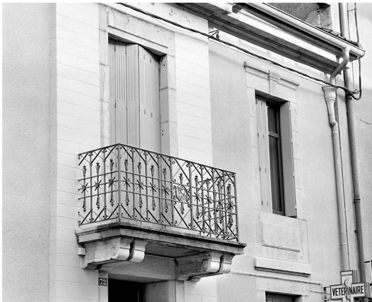
Façade antérieure : balcon et baies de l'étage.
