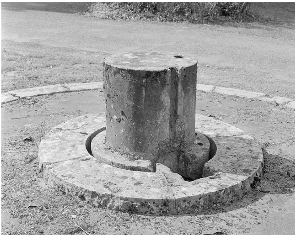
Base du pilier central, sur lequel reposait l'instrument. Noter la rainure ménagée pour la câble du poids du moteur de la lunette.
