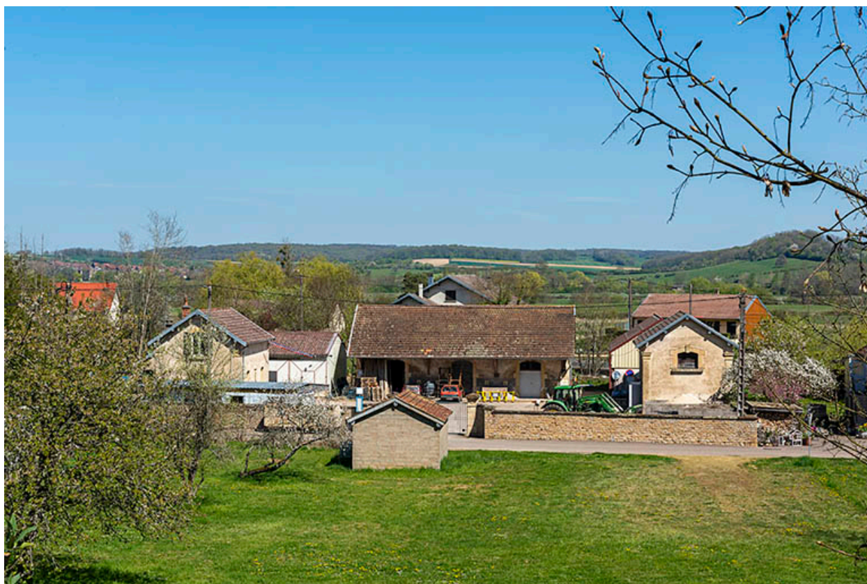
L'ensemble des bâtiments de l'ancien abattoir.
