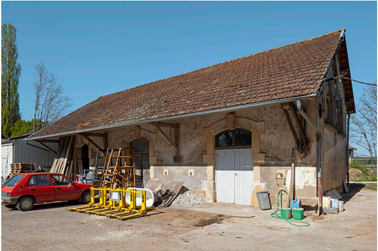
Le bâtiment central, de face.
