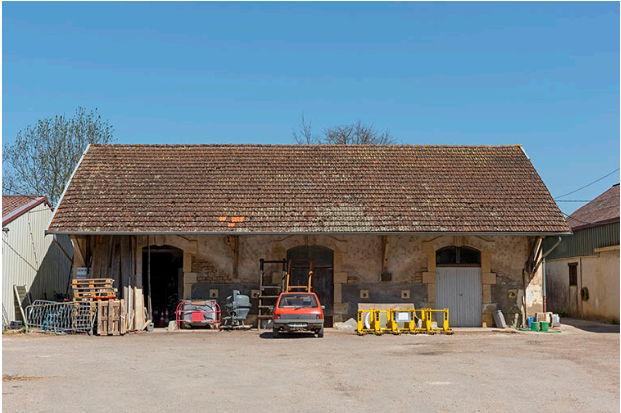
Le bâtiment central, de face.
