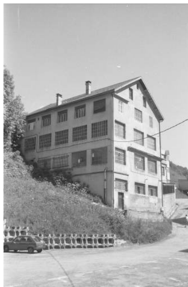
Façades postérieure et latérale droite.
