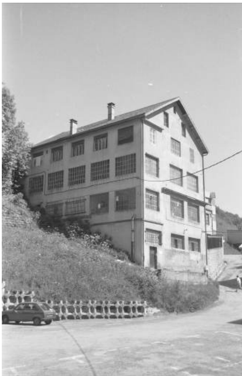
Façades postérieure et latérale droite.
