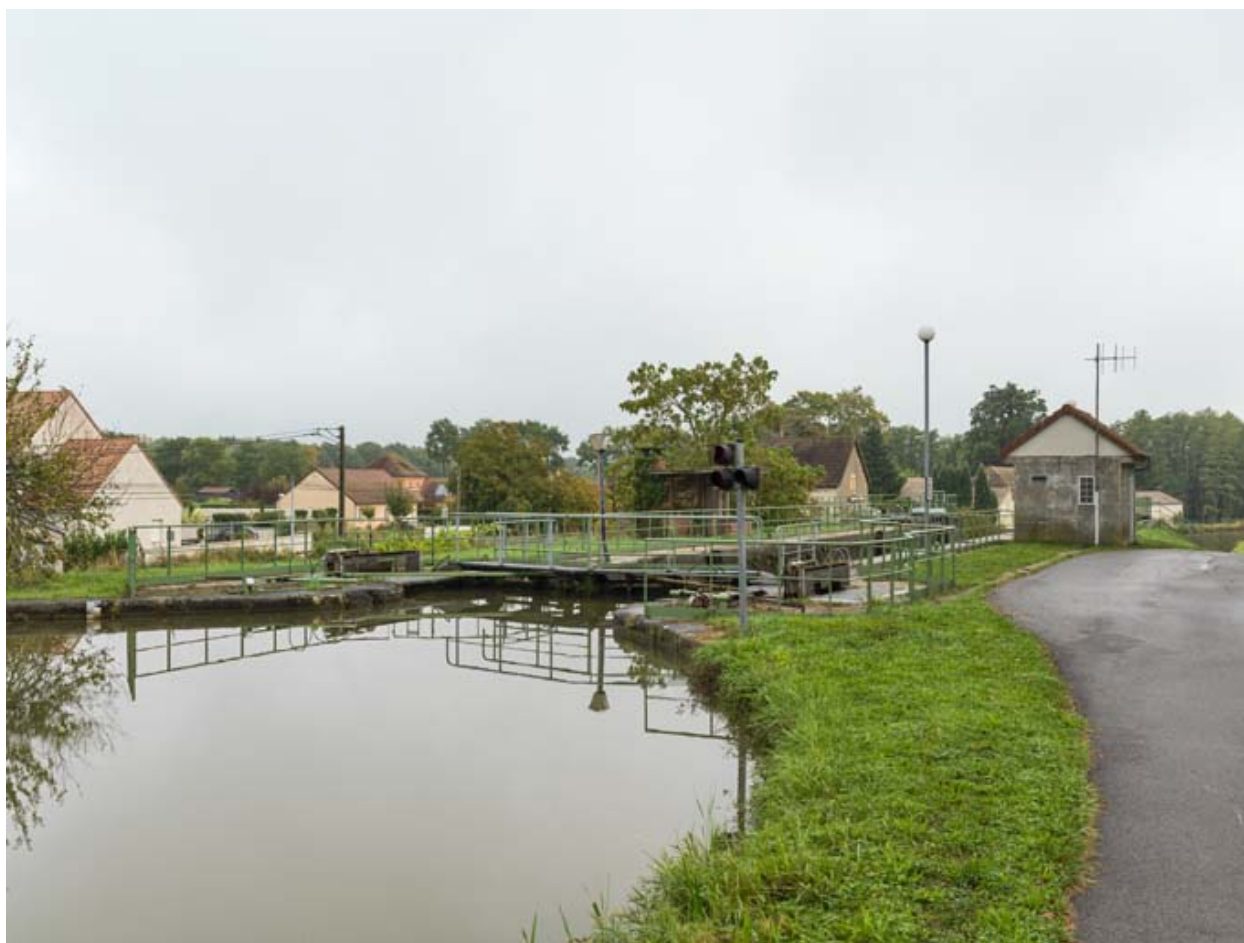
Vue d'ensemble du site d'écluse.
