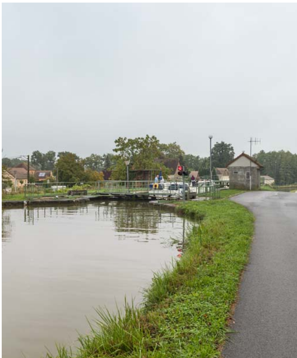
Vue d'ensemble du site d'écluse.
