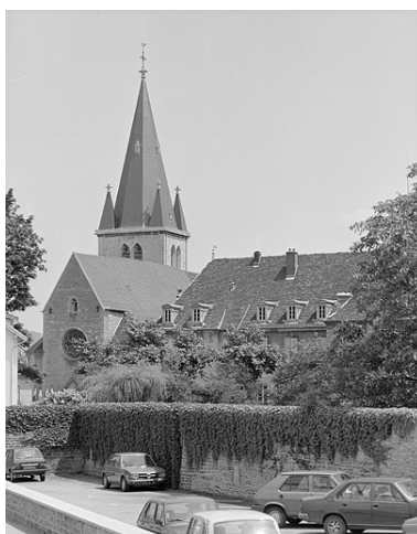
Eglise paroissiale Saint-Désiré. Phot. Yves Sancey IVR43_19853900270X
