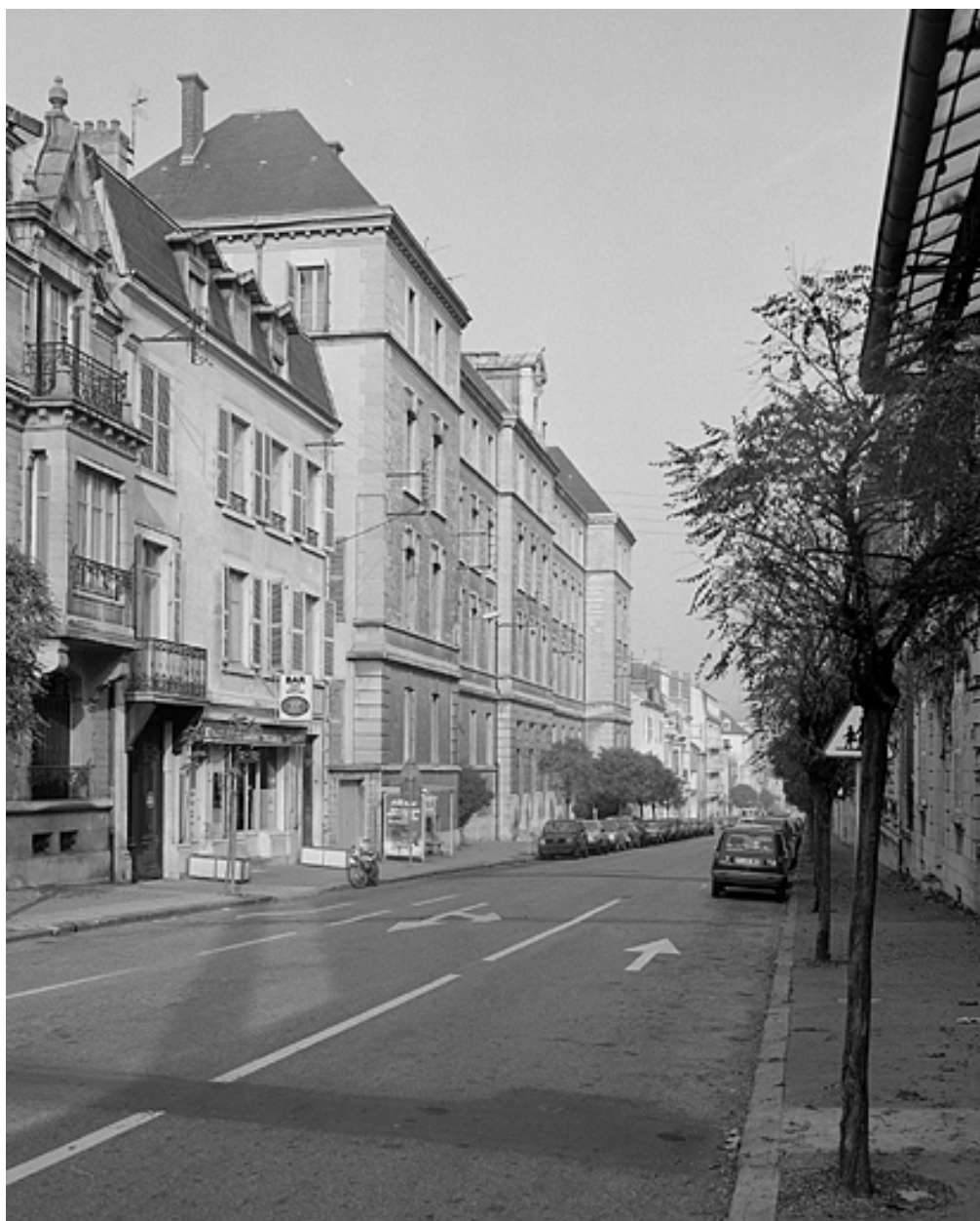
Lycée de jeunes filles situé avenue Aristide Briand.
