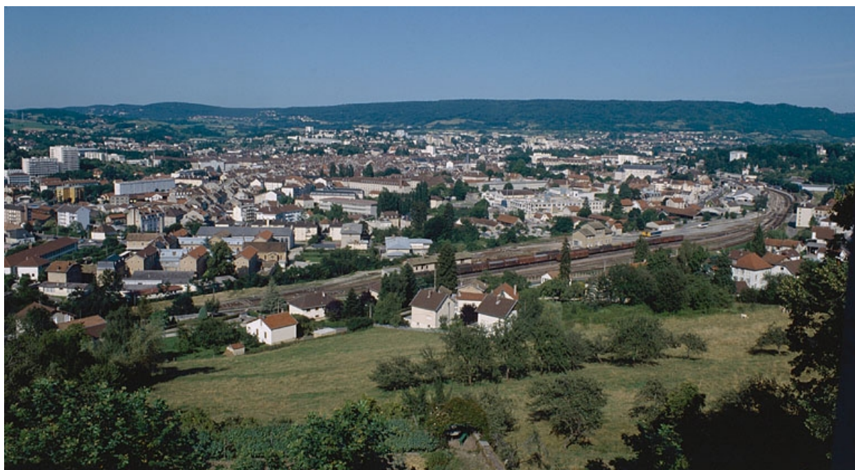
Vue de la ville depuis Montciel.
