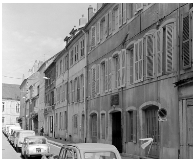
Rue Tamisier. Phot. Yves Sancey IVR43_19833900397X
