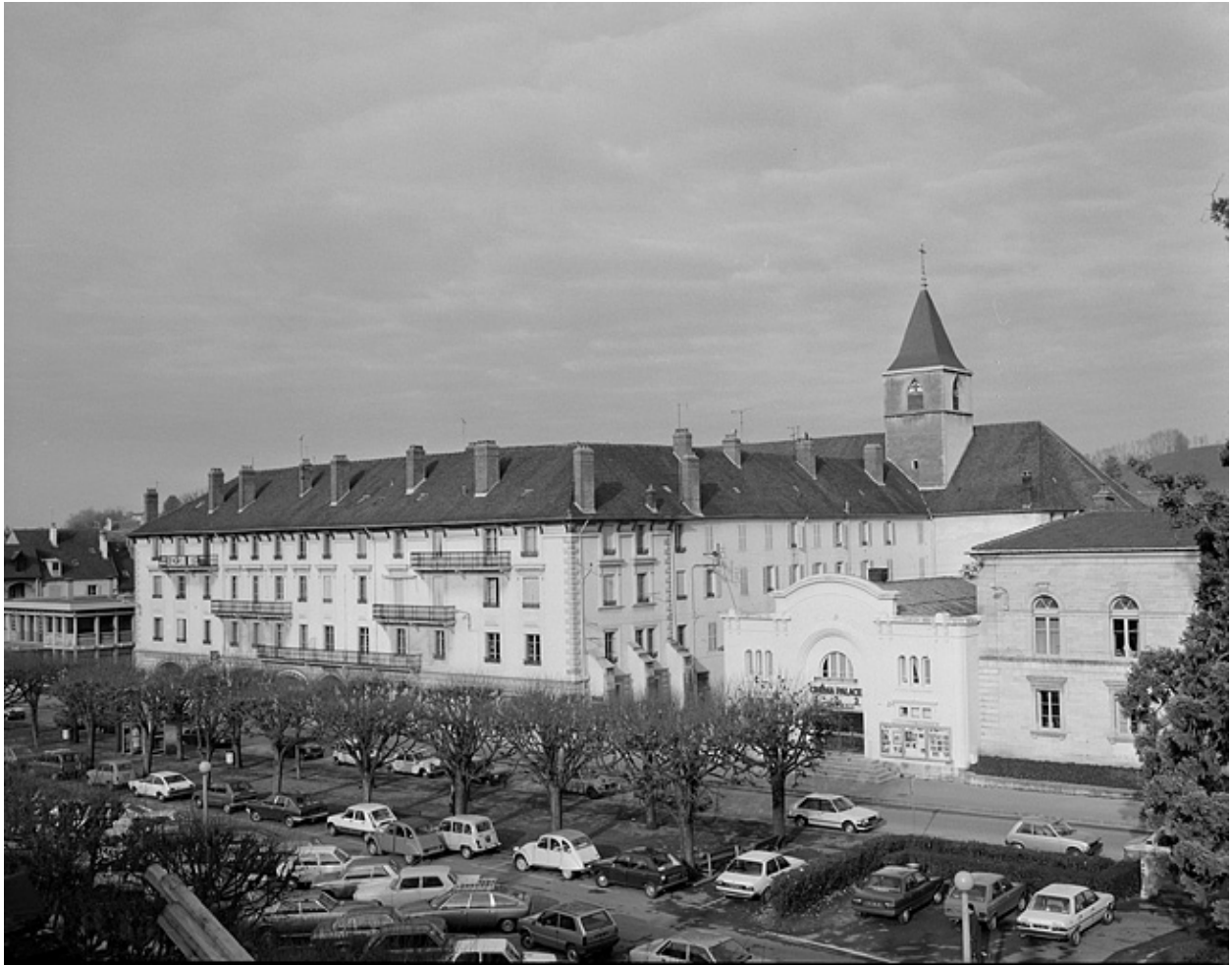
Couvent de cordeliers, actuellement église paroissiale Saint-Pierre et Saint-Paul, demeure et édifice commercial, situé rue des Cordeliers.
