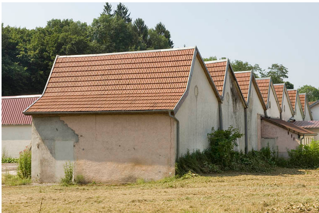
Atelier de fabrication couvert de sheds.
