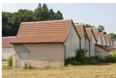
Atelier de fabrication couvert de sheds. Phot. Jérôme Mongreville IVR43_20097000770NUC2A
