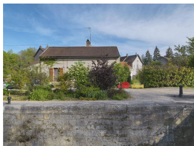
Maison éclusière de face. Phot. Thierry Kuntz IVR26_20122102447NUC4A
