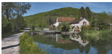
Vue d'ensemble de l'amont du site d'écluse. Phot. Thierry Kuntz IVR26_20122102459NUC4A
