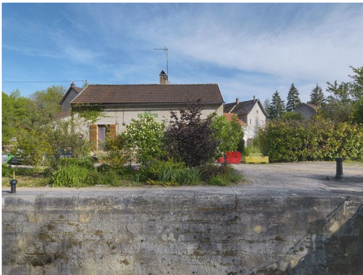
Maison éclusière de face.
