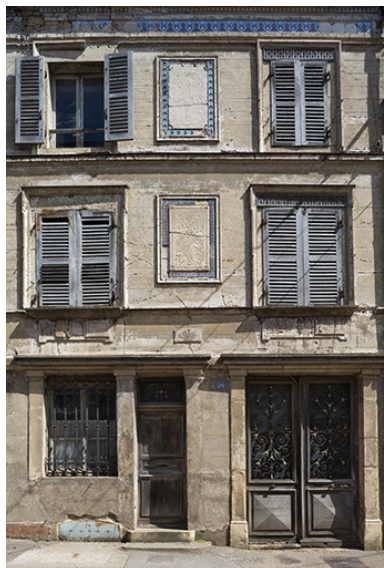
Le rez-de-chaussée et les deux étages carrés. Phot. Jérôme Mongreville IVR43_20217000334NUC4A
