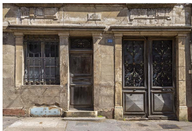
Pilastres, ferronnerie, menuiserie, bas-relief sur la façade. Phot. Jérôme Mongreville IVR43_20217000332NUC4A
