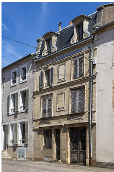
La façade antérieure, de trois quarts droite. Phot. Jérôme Mongreille IVR43_20217000331NUC4A
