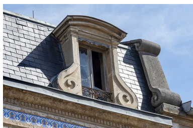
Détail de la lucarne sur le brisis, à droite. Phot. Jérôme Mongreville IVR43_20217000340NUC4A
