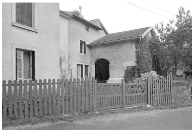
Entrée de grange sur une des fermes. Phot. Jérôme Mongreville IVR43_19963901455X
