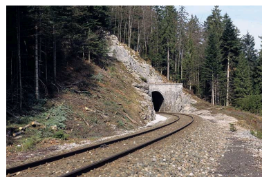
Voie et tête côté La Cluse. Phot. Yves Sancey IVR43_20053900265ZA
