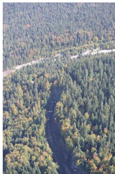
Vue aérienne de la tête côté Andelot-en-Montagne, depuis l'ouest.
