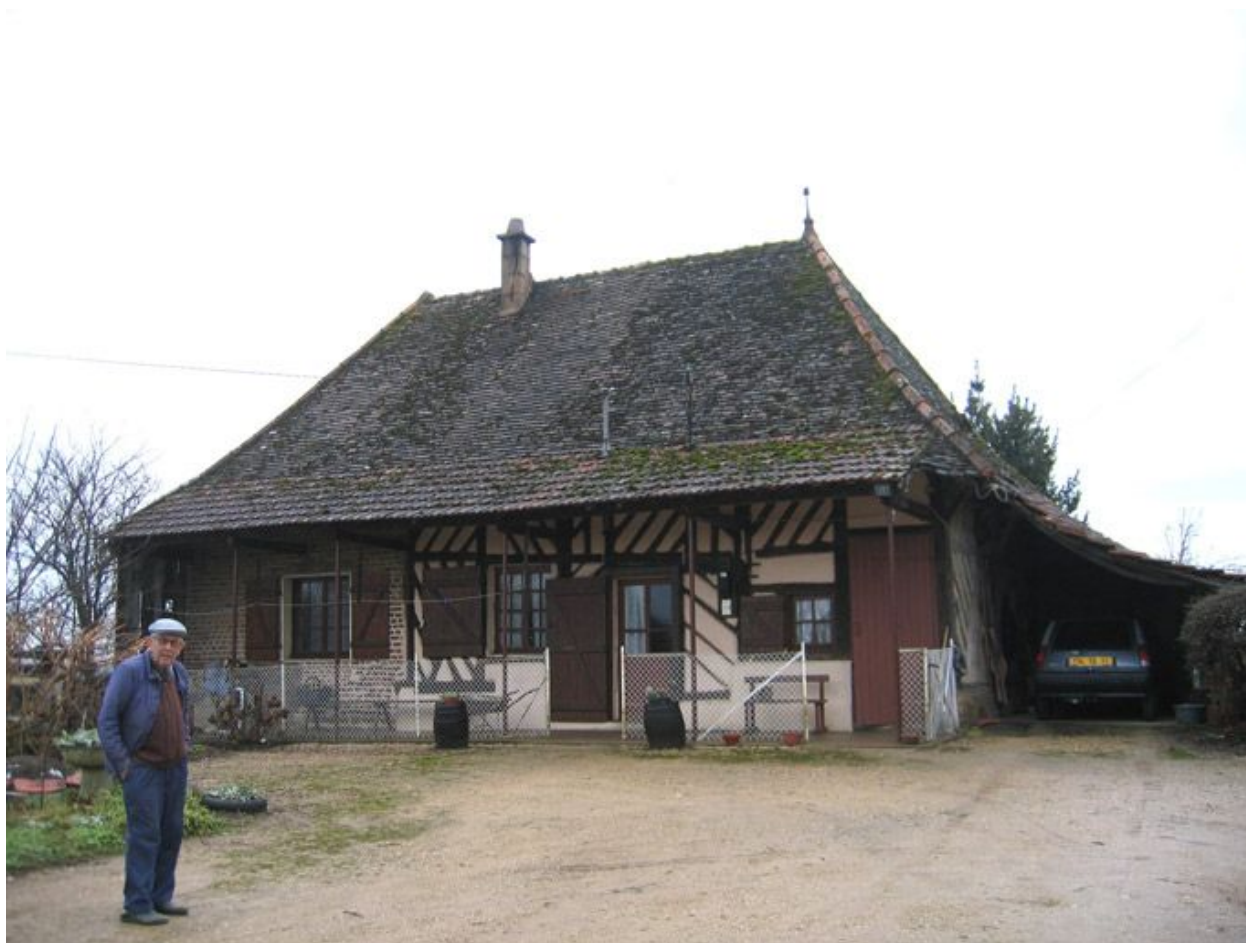
Vue d'ensemble de la façade.
