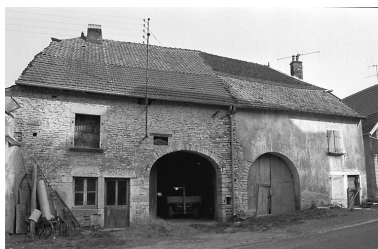
Ferme située 17 Grande Rue : façade antérieure. Phot. Bernard Lardière IVR43_19797000167Z
