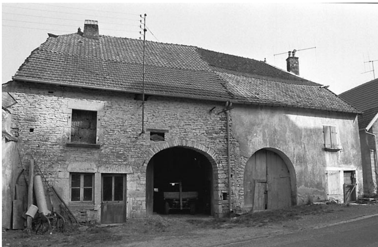
Ferme située 17 Grande Rue : façade antérieure.
