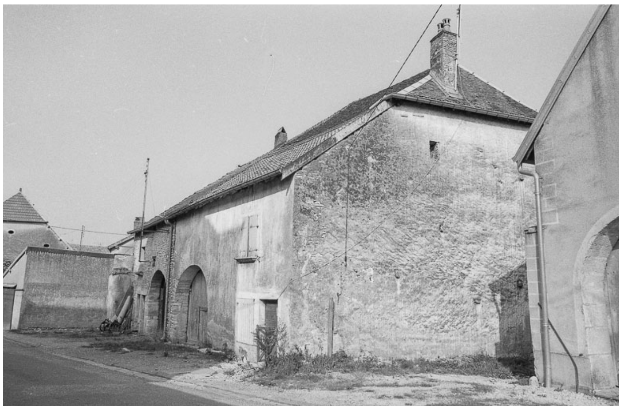
Ferme située 17 Grande Rue : façade antérieure vue de trois quarts droit.
