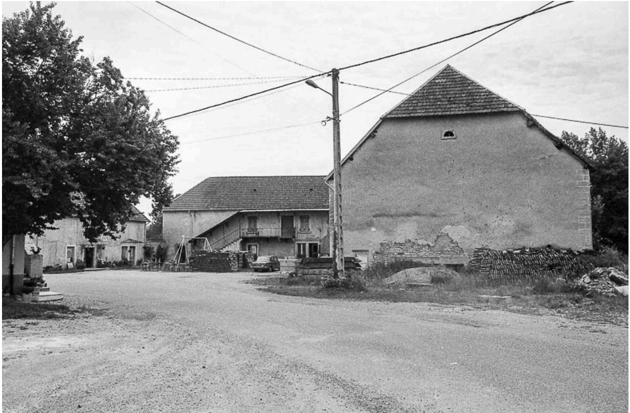
Vue d'ensemble des bâtiments en U.
