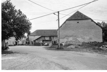
Vue d'ensemble des bâtiments en U. Phot. Bernard Lardière IVR43_19817000250Z
