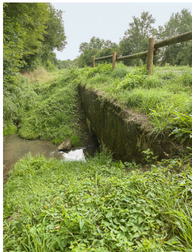
Vue de l'aqueduc. Phot. Pierre-Marie Barbe-Richaud IVR26_20175800142NUC2A
