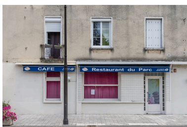
Vue de face, détail. Phot. Pierre-Marie Barbe-Richaud IVR26_20205800478NUC4A
