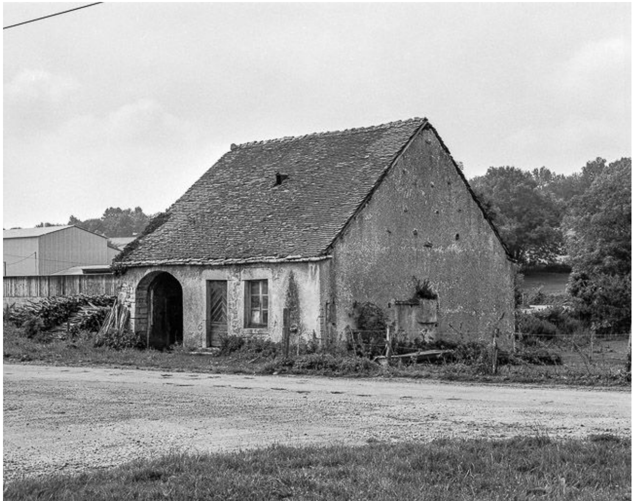
Ferme située 580 rue Saint-Néron.
