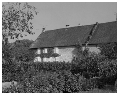
Façade postérieure. Phot. Yves Sancey IVR43_19843900196X
