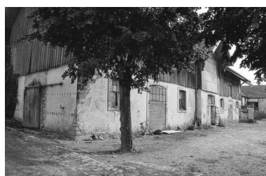
Maison située rue de l'Eglise. Phot. Bernard Lardière IVR43_19797000233Z
