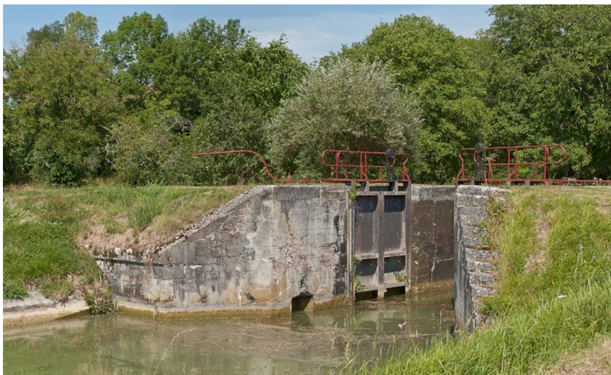
Vue du sas d'écluse en aval.
