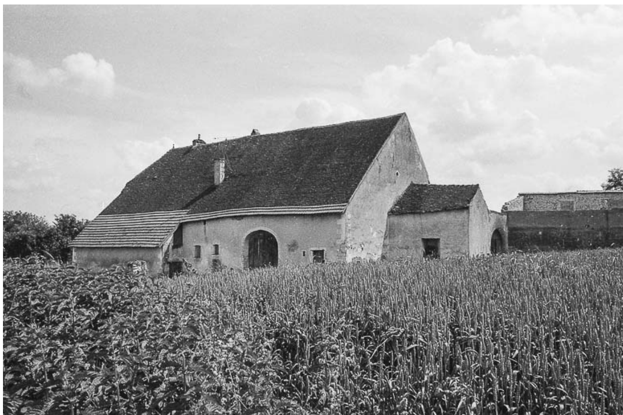
Ferme située rue des Carrés dite maison des Templiers.
