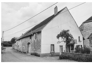
Fermes situées rue du Mont. Phot. Bernard Lardière IVR43_19817000192Z
