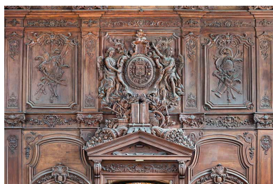
Vue d'ensemble. Phot. Jérôme Mongreville IVR43_20242500051NUC4A
