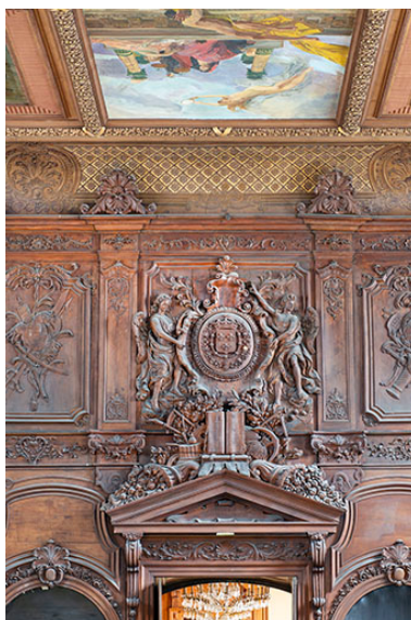
Vue d'ensemble. Phot. Jérôme Mongreville IVR43_20242500053NUC4A
