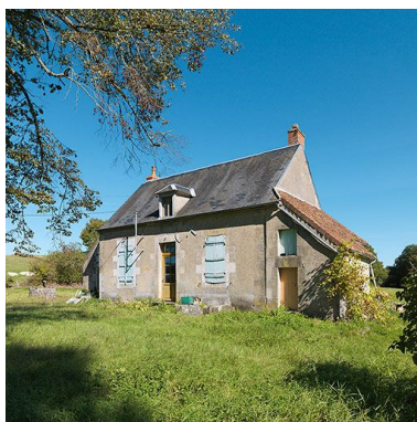
La maison éclusière, vue de 3/4. Phot. Thierry Kuntz IVR26_20135800115NUC4A
